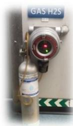
Calibración de detectores empleando gas patrón.
