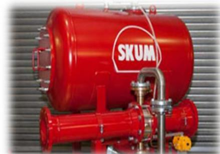
Se dispara el sistema para observar que la espuma se dosifique y mezcle correctamente.
