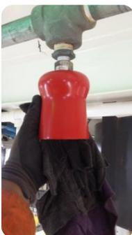
Se realiza un barrido de la línea a la tubería de descarga; con gas inerte para verificar que no se encuentre tapada o dañada.
