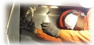
Se colocan cubre boquillas para evitar que la suciedad tape los puntos de descarga.
