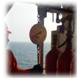
Se verifica que los cilindros estén dentro del % de peso adecuado, que estén vigentes sus pruebas hidrostáticas y libres de corrosión severa.
